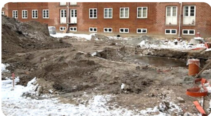
Udgravning til terrasse ved fælleslokalet ved blok D:
